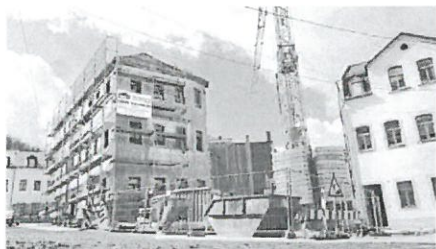
Ein weithin sichtbarer Kran zeugt vom Fortgang der Bauarbeiten am Wohnprojekt Altmarkt 18/20. FOTO: ANDREAS MOH AND
