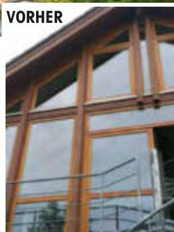
Die verwitterten Holzfenster werden mit dem modernen, langlebigen **Aluminium-Verkleidungs-System von PORTAS** in der passenden Holzoptik oder Farbe renoviert. Maßgenaue Aluminiumprofile werden mit Hinterlüftung von außen auf Rahmen und Flügel montiert.
