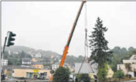
Mitte August fand in Kirchberg die Aufstellung von zwei Hauptverteilerpunkten für das Glasfasernetz des Unternehmens Unsere Grüne Glasfaser statt. Ausgehend von diesen beiden Knotenpunkten werden die Glasfaserbündel unterirdisch zu weiteren Verteilerpunkten im gesamten Ort gelegt und von dort gelangen sie weiter in alle interessierten Haushalte.
