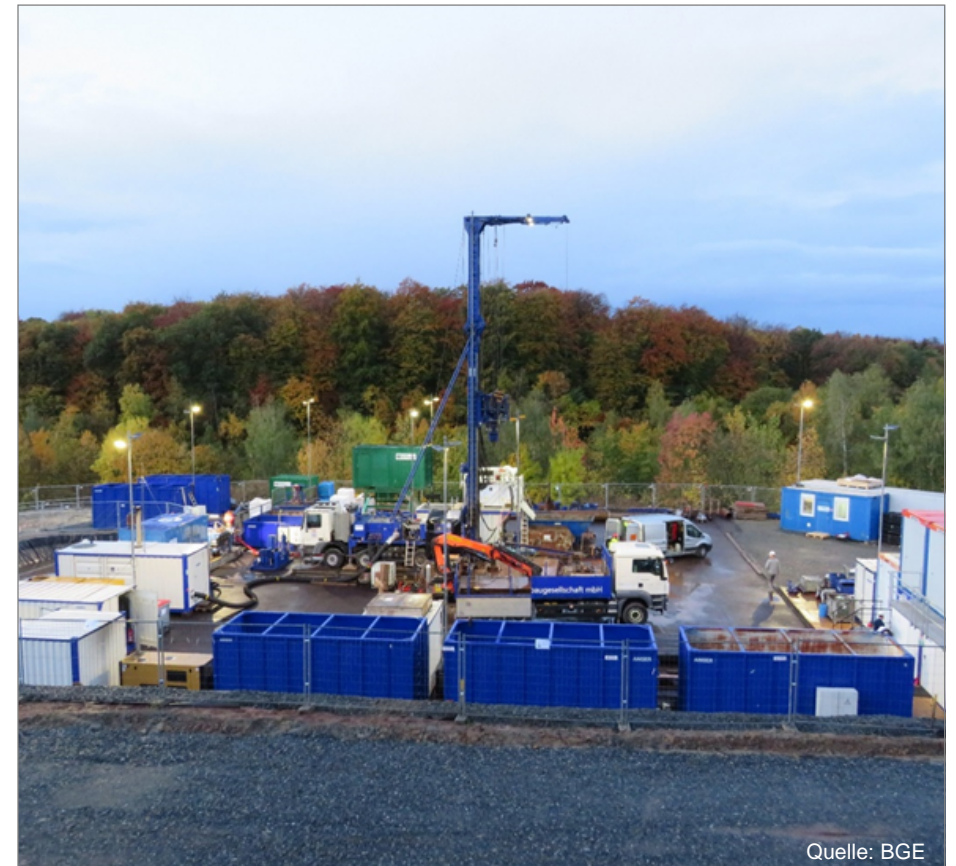
Bohrplatz für mitteltiefe Bohrung inkl. Messfahrzeug für Bohrlochmessung
